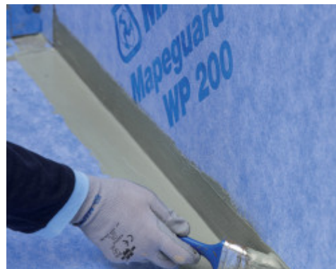
Εφαρμογή Mapeguard WP Adhesive πριν από την εφαρμογή Mapeguard ST για σφράγιση των γωνιακών αρμών
