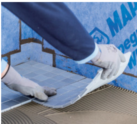
Τοποθέτηση πλακιδίων
